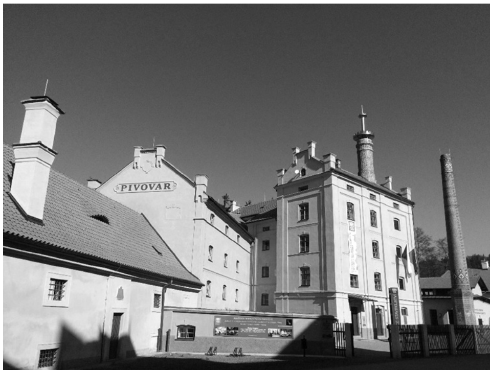
Obr. 1 - Pivovar v Plasích po rekonstrukci, dnes Centrum stavitelského dědictví. Foto autorka, 2017.
