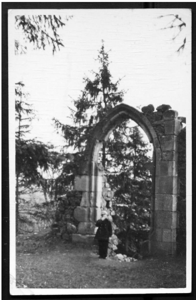
Obnovený portál na hradě Lopata na dobovém snímku, nedatováno, dnes mobiliář zámku Kozel, inv. č. KZ4871. Foto: NPÚ, fotoarchiv.
